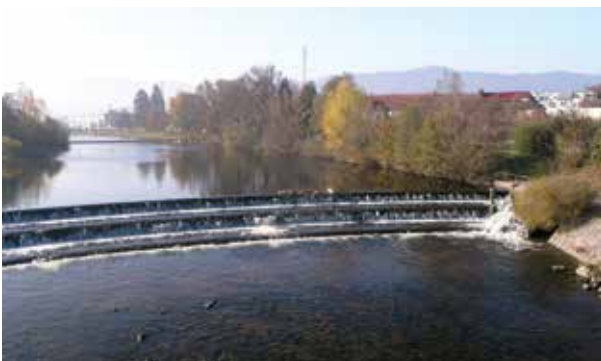
Abb. 5.14: Neben der Fragmentierung von Fließgewässern führen Querbauwerke zur Entstehung von Staubereichen. In diesen kommt es aufgrund der langsameren Fließgeschwindigkeit zu einer verstärkten Erwärmung des Wassers.
