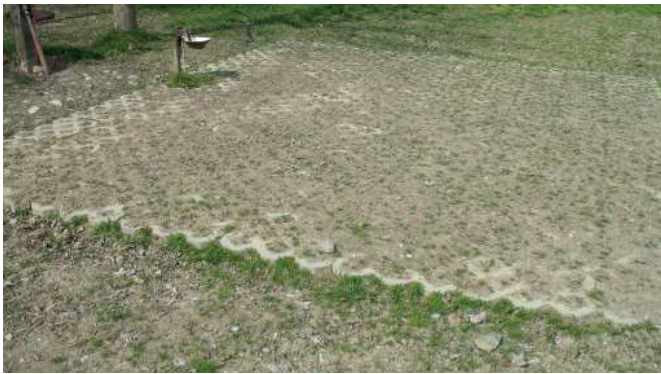
Bild 3: Befestigter Platz im Bereich einer Tränke.
