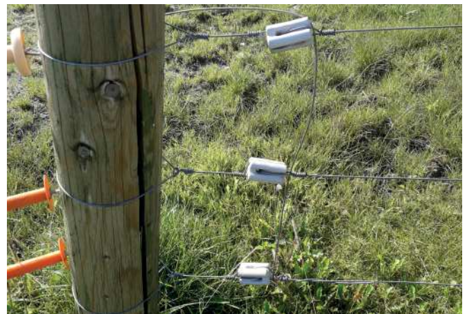
Bild 3: Eckpfosten mit zugfesten Porzellanisolatoren.
